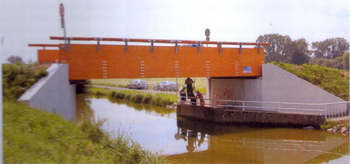
Obr. 1.2: Pohled na most
